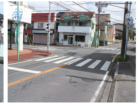
つくしが丘の信号交差点(補修前)
